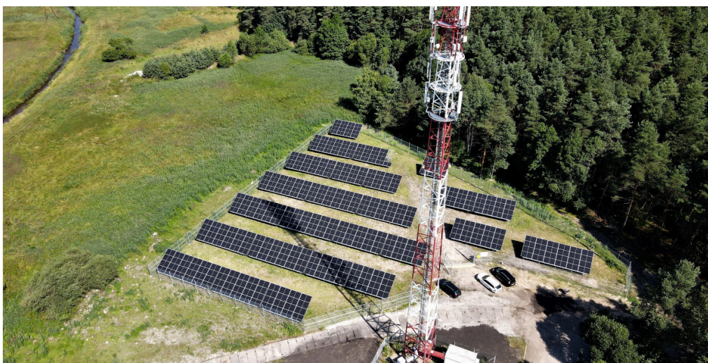
Instalacja fotowoltaiczna przy Miejskiej Oczyszczalni Ścieków w Kaletach — fot. Tygodnik Gwarek
